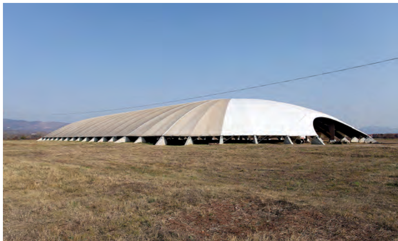
Fig. 1. The shelter constructed over the peristyle villa, view from the south-west (photo Ž. Cajić) Сл. 1. Заштитна конструкција изнад виле са перистилом, изглед са југозападне стране (фото Ж. Цајић)
